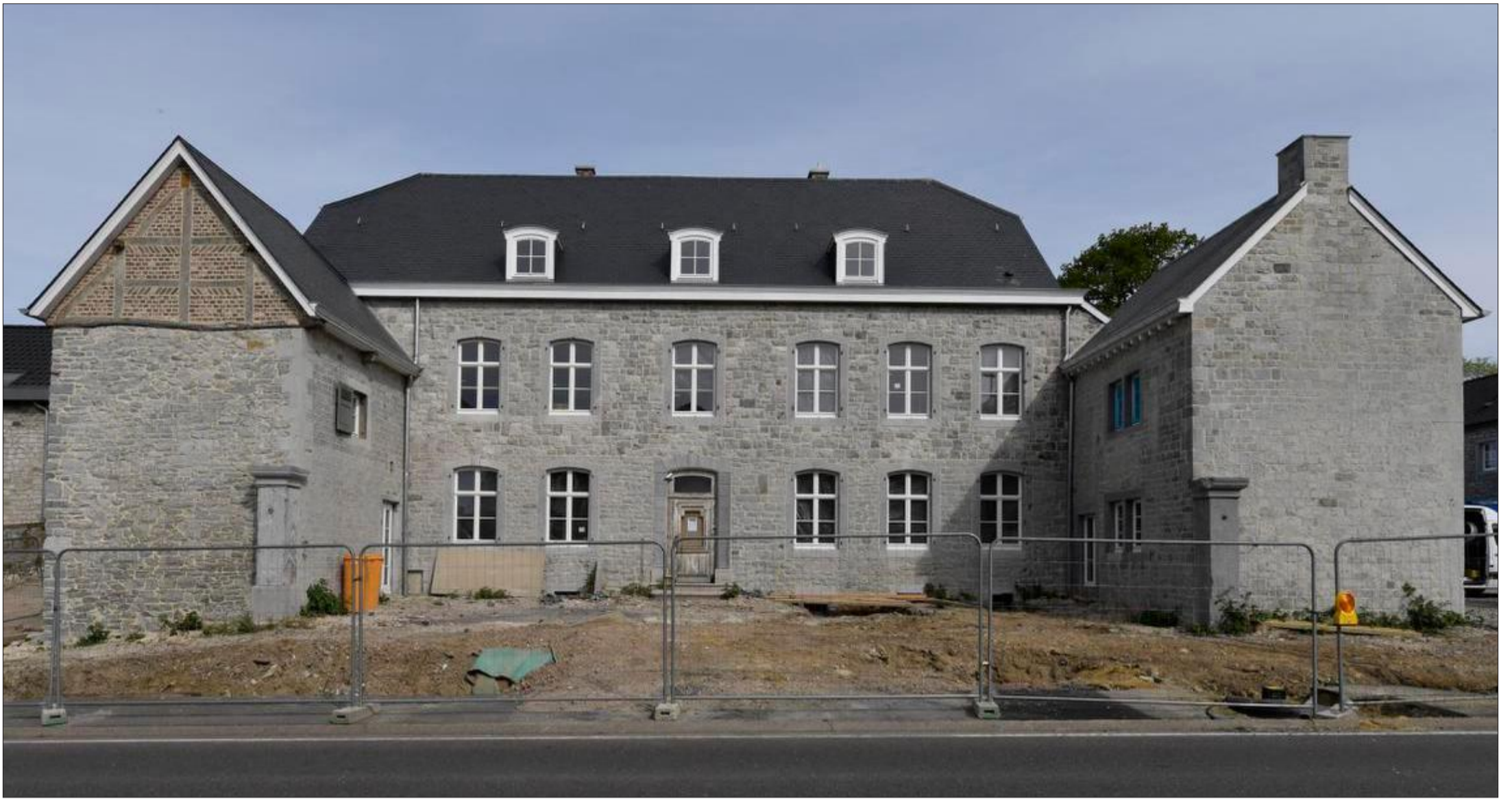
Die Außenhülle von Haus Trouet, bzw. Maison Visavis, wie der Bauherr das Anwesen getauft hat, wurde vollends saniert. Im Inneren gibt es derweil noch einiges zu tun.
